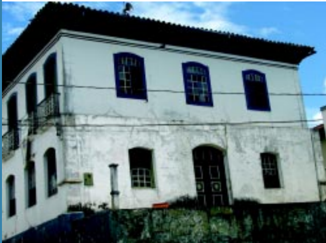
Casarão sem conservação
